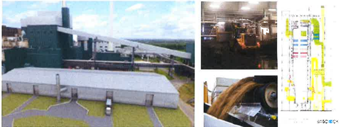
Abbildung 3: Optimierung der bestehenden Mitverbrennung durch Erweiterung der bestehenden Klärschlammagerhalle und Optimierung der vorhandenen Kesselanlagen
